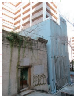
撮影:北大江まちづくり実行委員 三木さん 2020年 北側建物解体の時
