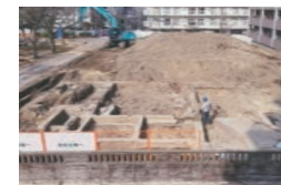
公園改修工事で戦前の建物基礎が。地下室へ降りる階段と思われる遺構も現れた。
